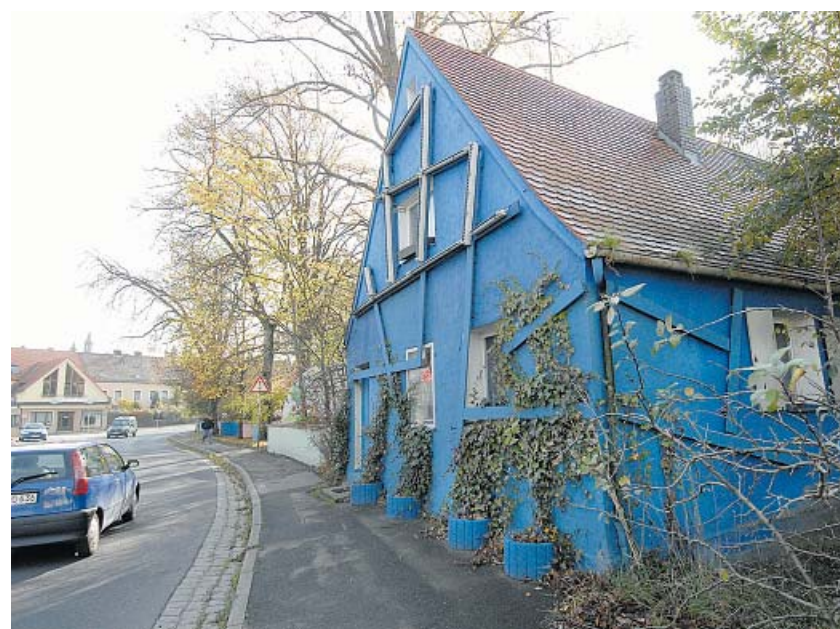
Das blaue Haus soll künftig einer neuen PPP-Zufahrt weichen. Wegen des hohen Verkehrsaufkommens ist die bisherige Einfahrt zu gefährlich. Foto: Lenk
